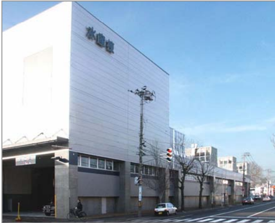
札幌中央卸売市場水産棟
