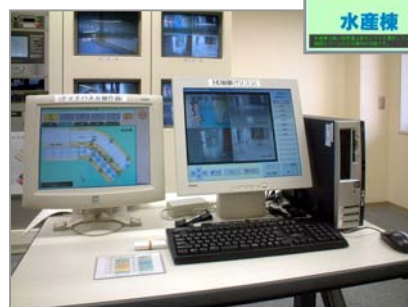
タッチパネルで 監視カメラを集中制御 3F機器室に設置した HDレコーダーの制御も 防災センターの パソコンで行なえます。
