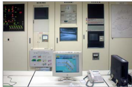
3F中央監視室～ 複合監視盤1、 複合監視盤2、 タッチパネル式コントローラ
