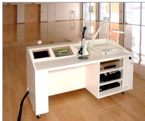
タッチパネルを 備えたAV操作卓 ～講堂
