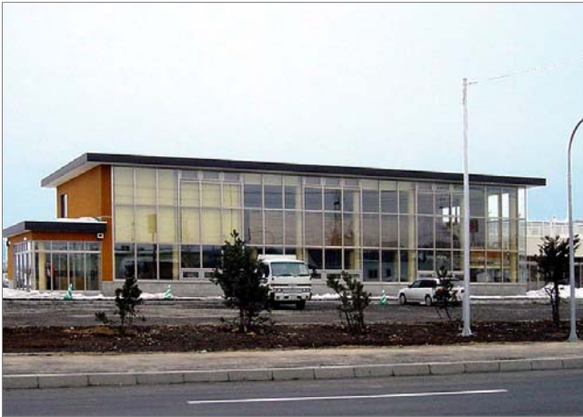
深川市「道の駅」外観
