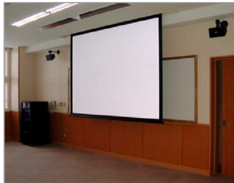
多目的教室に設置のスピーカー、120吋電動スクリーンと収納ワゴン
